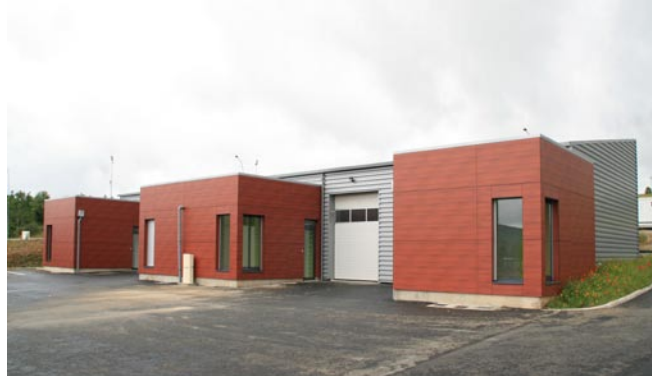
Atelier-relais au Causse d'Auge
